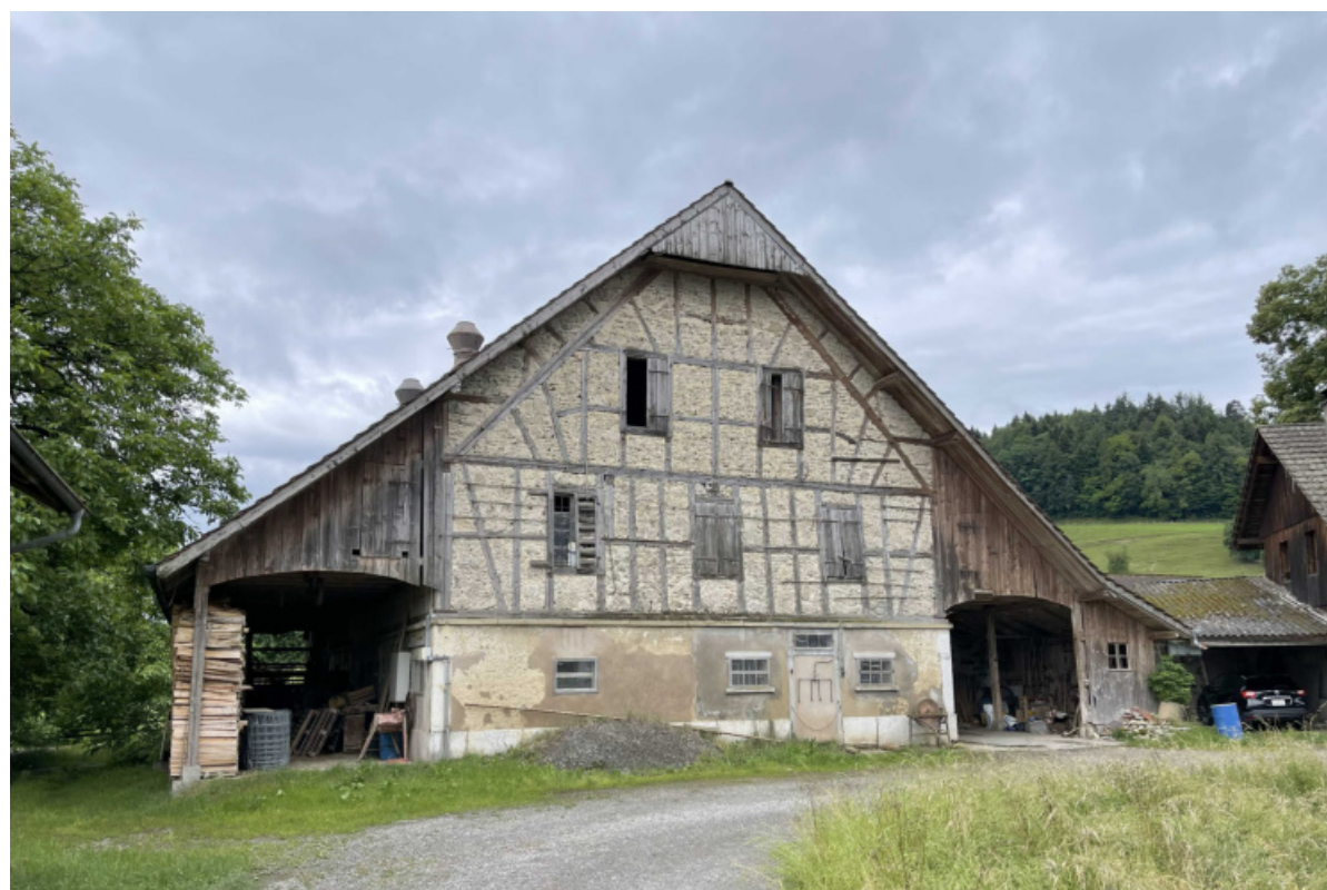
Scheune mit sichtbarem Fachwerk
